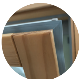
Guarnizioni perimetrali del battente saldate agli angoli
